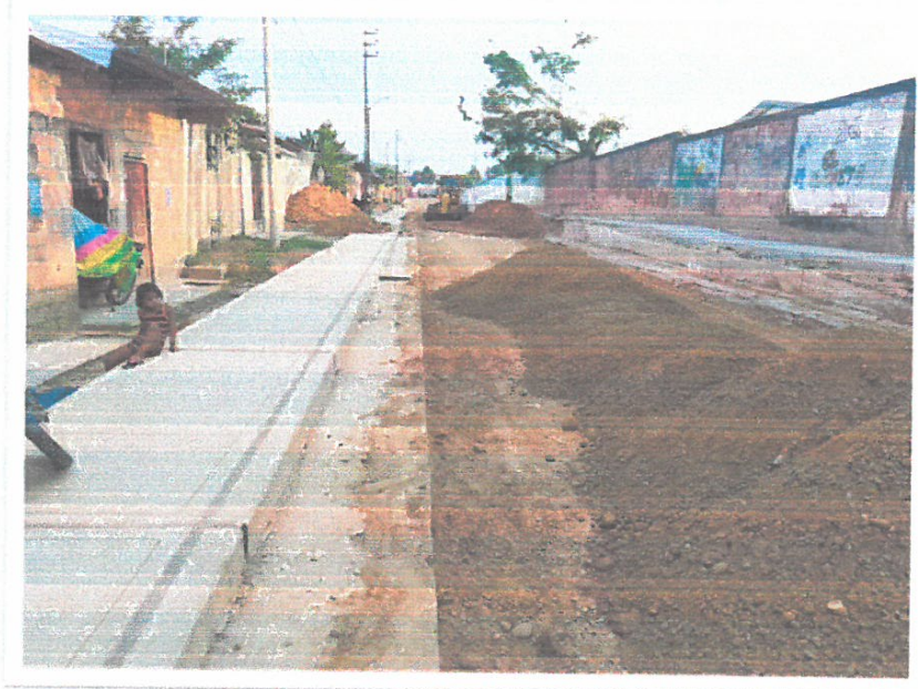
Verificación de los materiales empleados en la base.
